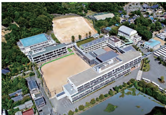
上空から見た校舎
